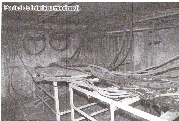
Poškodené zväzky kabeľáže
