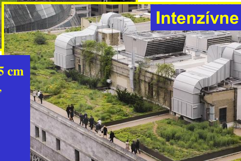
Obr. č. 15 Ukážka extenzívnej a intenzívnej zelenej strechy (archív MVO Ľudia a voda)
