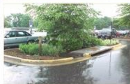
Obr. č. 12 Systémy zbierania dažďovej vody do koreňového systému stromov (archív MVO Ľudia a voda)
